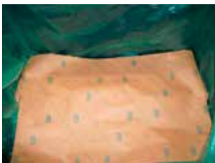
wieder eine Lage Branorostpapier auf das Material legen
